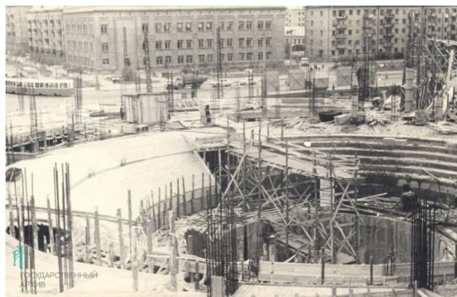
Рисунок 5. Возведение нового здания государственного Пермского цирка.
