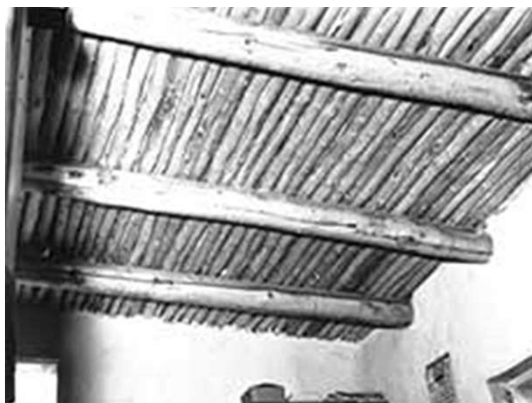
Рисунок 3 - Пример структуры древесины под традиционной плоской крышей, уменьшающей влияние тепловых потоков в помещении с открытых земляных поверхностей.
